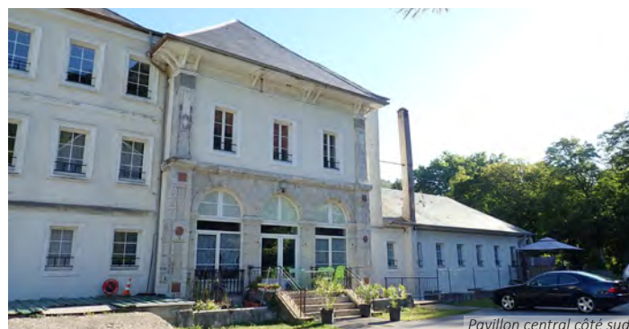
Pavillon central côté sud
