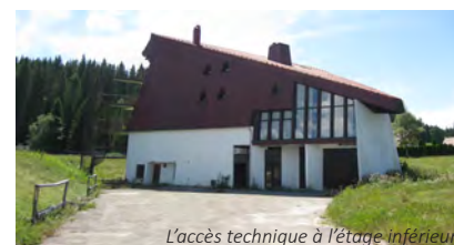
L'accès technique à l'étage inférieur
