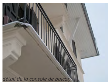
détail de la console de balcon
