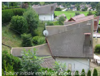
Toiture initiale en shingle et extension
